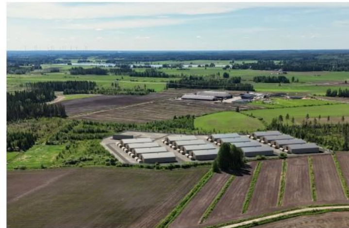
Haapajärven Pysäysperän sähkövarastosta tulee Suomen suurin ja sen on määrä käynnistyä 2027. Akkukontit suojataan lumelta ja jäältä sijoittamalla ne hallien sisään.
