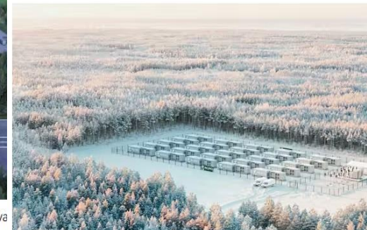
Nivalassa varastoidaan siirtoverkosta saatavaa sähköä. Akustokenttää ohjataan täysin automatisoidulla järjestelmällä. Kuva: Ingrid Capacity, Studio3D
